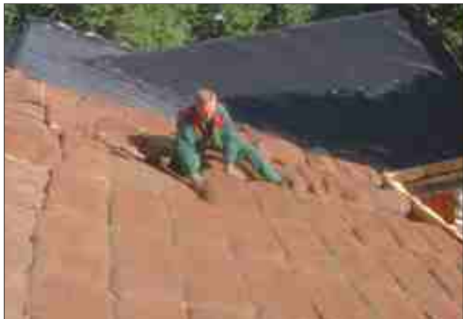
Die Säcke werden bündig aneinander gelegt.
