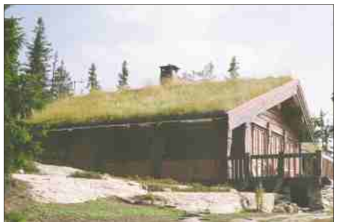
Das fertige Ergebnis ist ein kräftig bewachsenes Grasdach.
