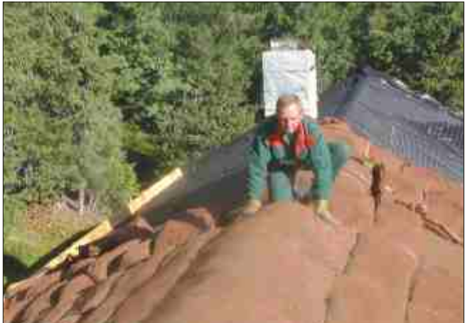
Legen Sie die Säcke quer über den Dachfirst.
