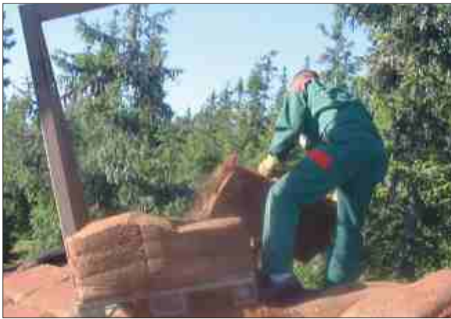
Problemlos auf das Dach gehoben, ca. 17 kg pro Sack oder 400 kg pro Palette.
